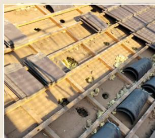
**Dégât totale sous le toit, causer par une fouine**
