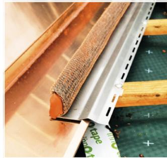
**Marder Protect™ Standard** ne nécessite pas de préparation spéciale. Accrocher et fixer les profils dans la rainure d'écoulement d'eau existante.
